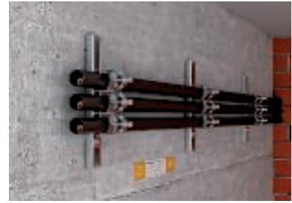
Több cső helytakarékos szerelése egymás mellett kengyeles bilincsekkel
