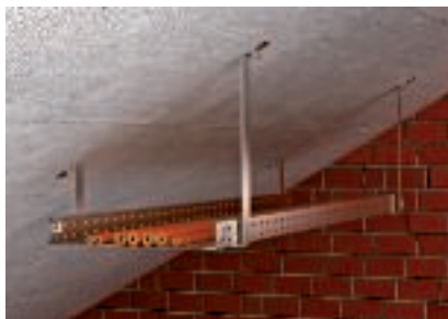
Szerelés dőlt mennyezetre, egyedileg igazított födémkengyellel
