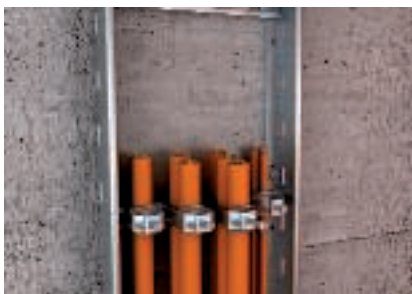
Kábelek rögzítése egyenként vagy csoportosan, kengyeles bilincsekkel
