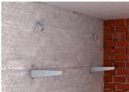
A konzol és a csatlakozóelem rögzítése a falra
