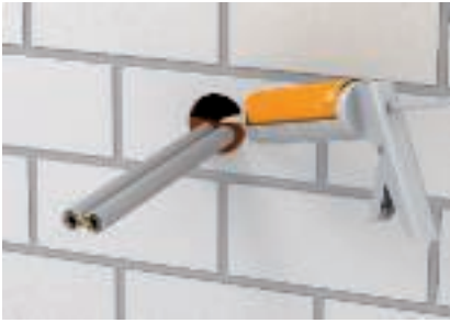
A nyílás lezárása FBA-SP réskitöltő masszával
