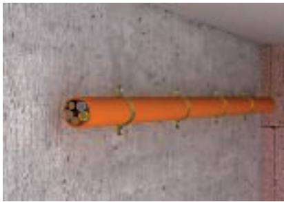
A kábelek vízszintes szerelése a falon
