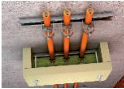
A húzásmentesítő szerelése profilsínen rögzített kábeleken
