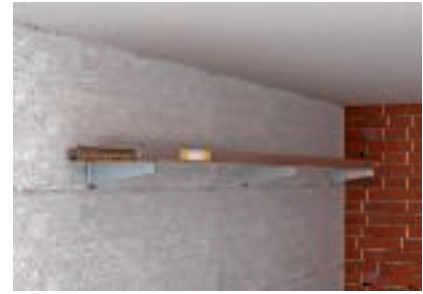
Vezetékek rögzítése oldalfalra
