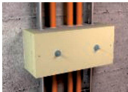
Hatásos alátámasztás ZSE90 húzásmentesítővel
