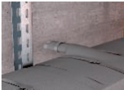
Kábelkiállítás bandázsolással
