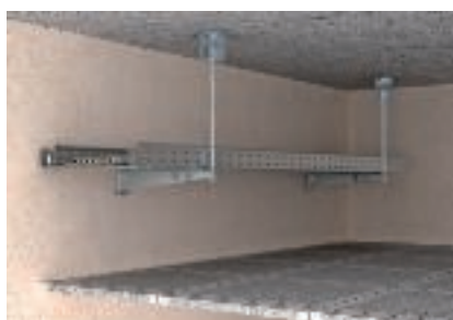
Fali szerelés, egy- és kétszintes kialakítás lehetséges
