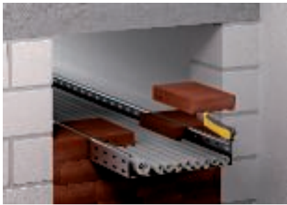
A méretre vágott blokkok beépítése
