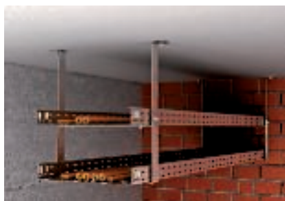
Kétszintes mennyezeti szerelés födémkengyellel és toldóval
