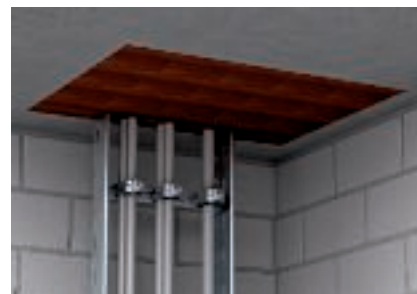
A blokkok földemáttörésbe szorosan illeszkedő beépítése
