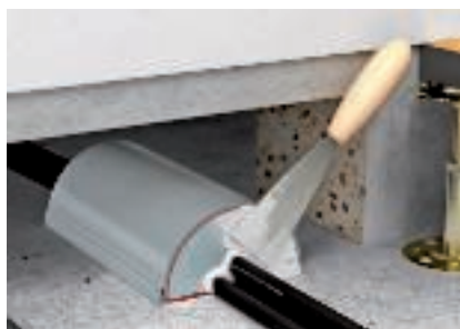
A felület füstgáz tömör lezárása ASX-szel
