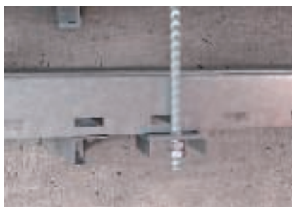
A függőleges menetes rúd rögzítése a csatlakozóelemhez
