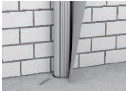
A tűzvédelmi bandázs installálása
