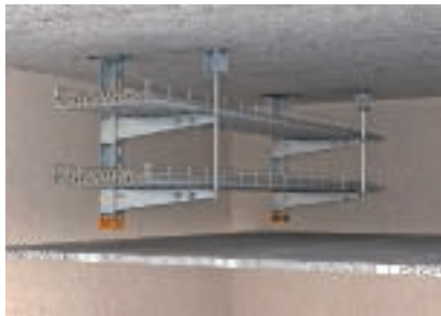
Kétszintes földmfüggesztés, egy oldalon elhelyezett konzolokkal
