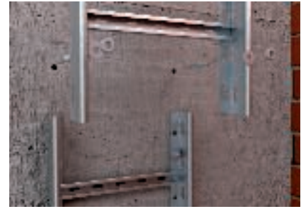
Toldás kialakítása hosszoldó nélkül
