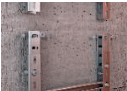
Toldáspont csavarozott összekötővel
