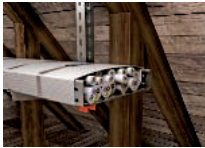
Bandázsolás alkalmazása nagy tűzterhelésű környezetben
