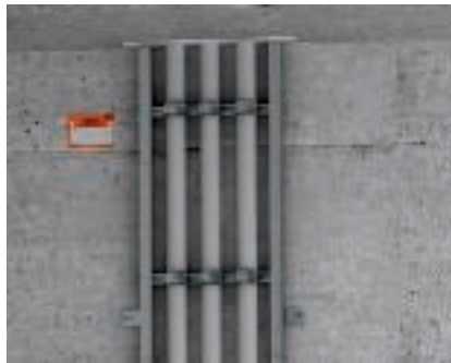
Szerelés oldalfalra Kábelhágcsó falra szerelése rögzítőszegletekkel.
