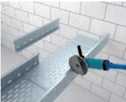
T-leágazóidom készítése beépíthető sarokelemmel Az oldalpofák kitérése a nagyfeszítvú tálcából.
