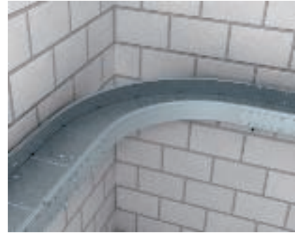
90°-os sarokidom szerelése Sarokidom és nagyfeszítvú kábeltráca összekötése. A sarokidomot és a nagyfeszítvú kábeltrát a külső összekötőkkel, illetve toldásponti takarólemezzel kell összekötni.
