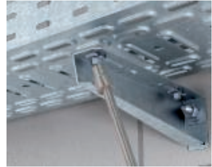
Tálca rögzítése konzolra gyorsrögzítővel A kábeltálca rögzítése a konzolra gyorsrögzítővel.
