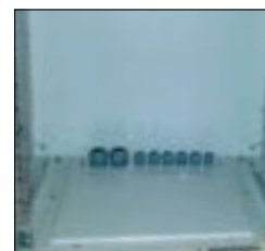
hátsó kábelvezető lap tömszelencékkel
