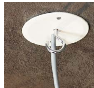
A V 68 S fedéllel ellátott KB típusú dobozokból kivezetett kábellel és KBP típusú csillárhorggal.
