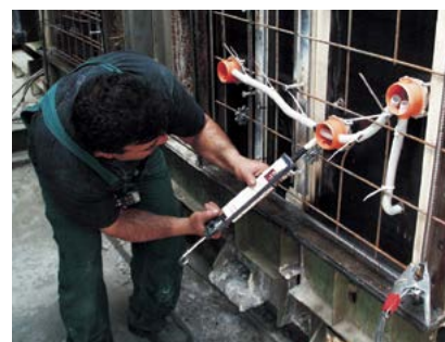
Az átvezetések tömítése (gitt).
