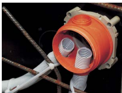
A KBT palástjába szerelt hajlékony csövek.
